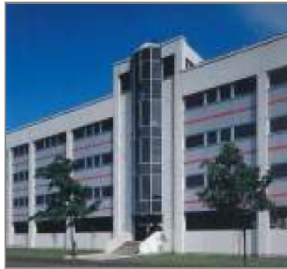
Insinööritoimisto Olof Granlund Oy, Helsinki
