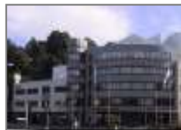
Insinööritoimisto Granlund Tampere Oy
